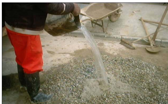
Figura 3. (a) Ausência de controle da dosagem do concreto (b) dosagem da água de amassamento.
