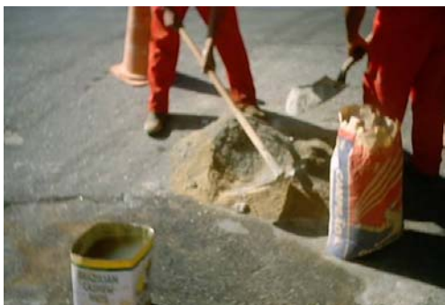
Figura 3. (a) Ausência de controle da dosagem do concreto (b) dosagem da água de amassamento.
