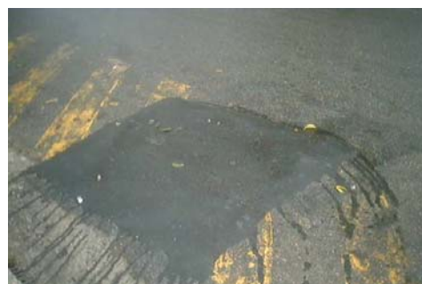
Figura 5. (a) Imprimadura executada com base molhada (b) imprimadura escorrendo para a sarjeta.
