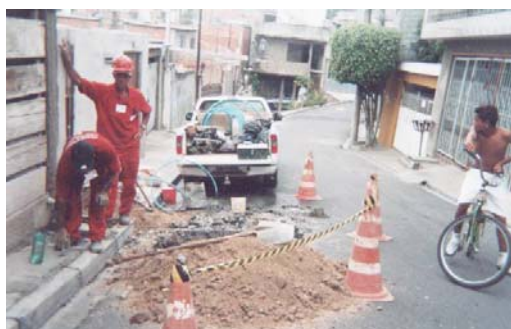
Figura 1. (a) Não utilização de lona para manter a limpeza do pavimento (b) reaproveitamento de material sem seleção prévia.
