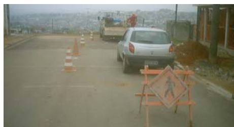
Figura 2. (a) Sinalização da obra inadequada (b) sinalização adequada.
