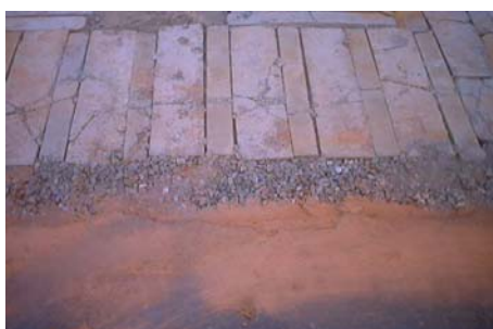
Figura 4. (a) colocação correta do SOPAC (b) Utilização de SOPAC trincado como base (c) recalque da base.
