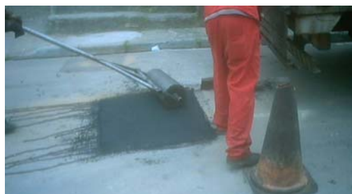
Figura 7. (a) compressão da massa asfáltica inadequada (b) compressão adequada.
