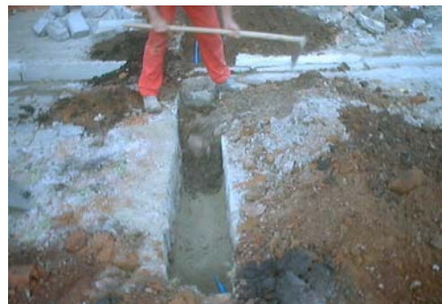
Figura 1. (a) Não utilização de lona para manter a limpeza do pavimento (b) reaproveitamento de material sem seleção prévia.
