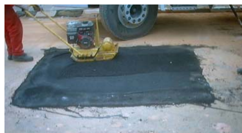
Figura 7. (a) compressão da massa asfáltica inadequada (b) compressão adequada.
