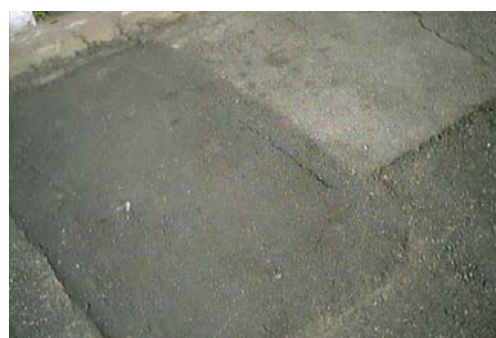
Figura 6. Defeitos ocasionados por deficiência na compactação da base.
