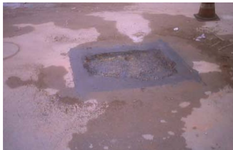
Figura 5. (a) Imprimadura executada com base molhada (b) imprimadura escorrendo para a sarjeta.
