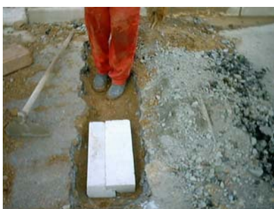
Figura 4. (a) colocação correta do SOPAC (b) Utilização de SOPAC trincado como base (c) recalque da base.
